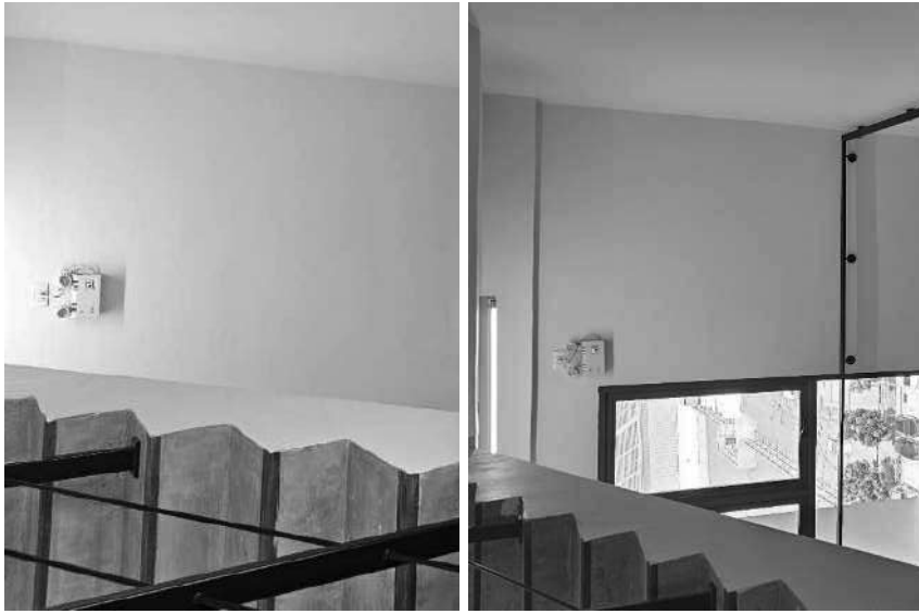
ภาพตัวอย่างไฟส่องสว่างฉุกเฉิน (บันไดหนีไฟ)
