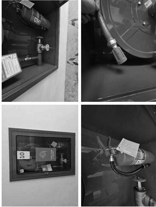
ภาพตู้ FHC สายฉีดน้ำดับเพลิง และถังดับเพลิง (เชิงลิฟต์ดับเพลิง) มีการตรวจสอบเบื้องต้นจากทางฝ่ายอาคาร
