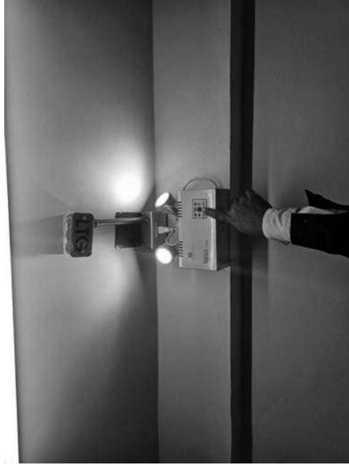
ภาพตัวอย่างการทดสอบไฟส่องสว่างฉุกเฉิน (บันไดหนีไฟ)
