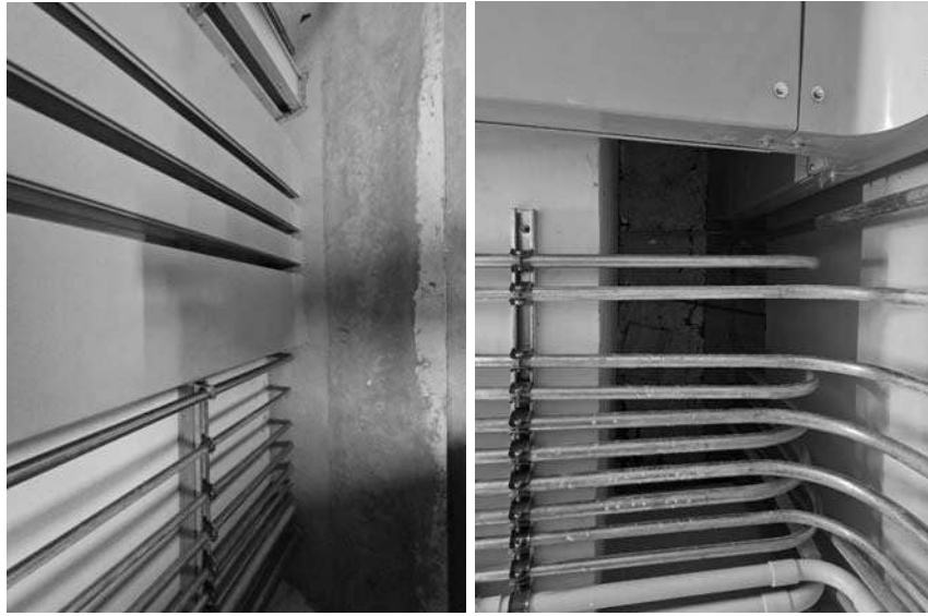
ภาพการปิดช่องเปิดระหว่างชั้น (ซารุปงานระบบไฟฟ้า) ป้องกันการแพร่กระจายควันไฟ
